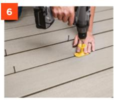
**FASTEN AT EACH JOIST**
